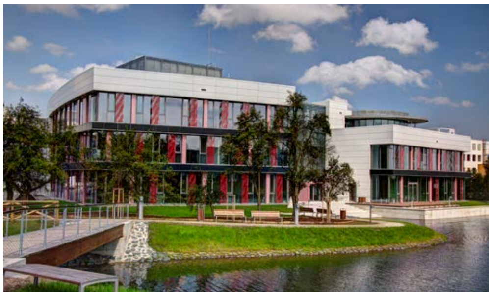
Technologický park Brno Saint-Gobain Construction Products CZ, a. s., divize GLASSOLUTIONS
