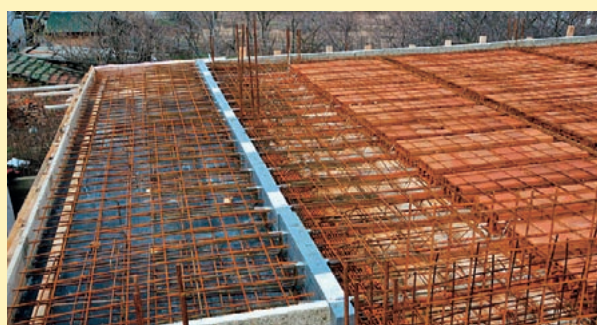
Přerušení tepelného mostu v rovině stropu pomůže zvýšit povrchovou teplotu podlahy a snížit riziko tvorby plísní.
