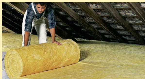
Zaizolované podlahy na půdě lze řešit jak nepochozí, tak s pochozí úpravou. (dále v katalogu)
